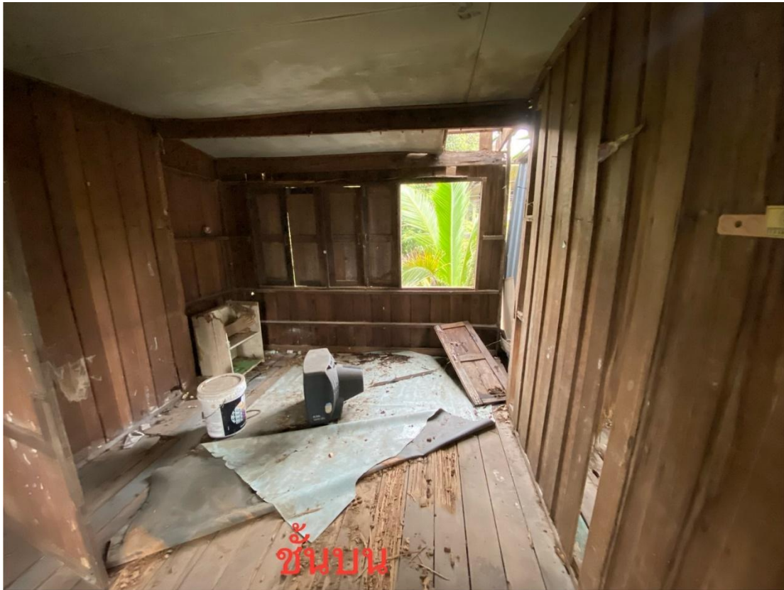
ภาพถ่ายบริเวณชั้นบน
