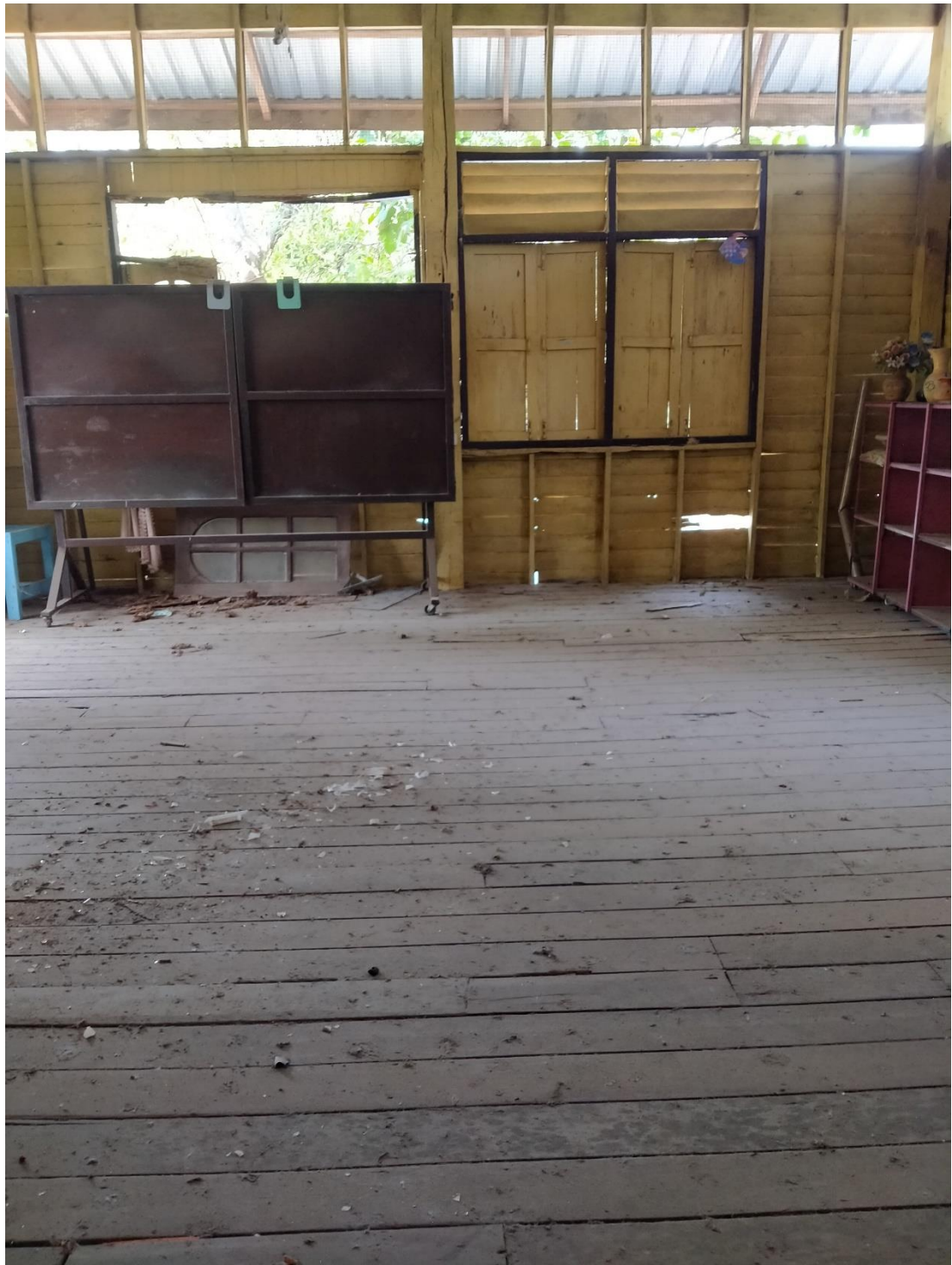
ภาพถ่ายชั้นบนอาคาร
