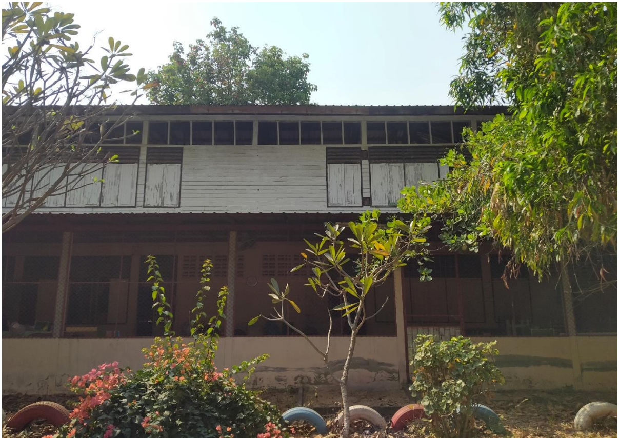
ภาพถ่ายบริเวณด้านหลังอาคาร
