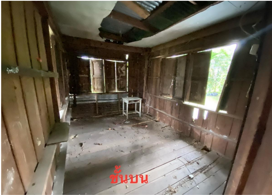
ภาพถ่ายบริเวณชั้นบน
